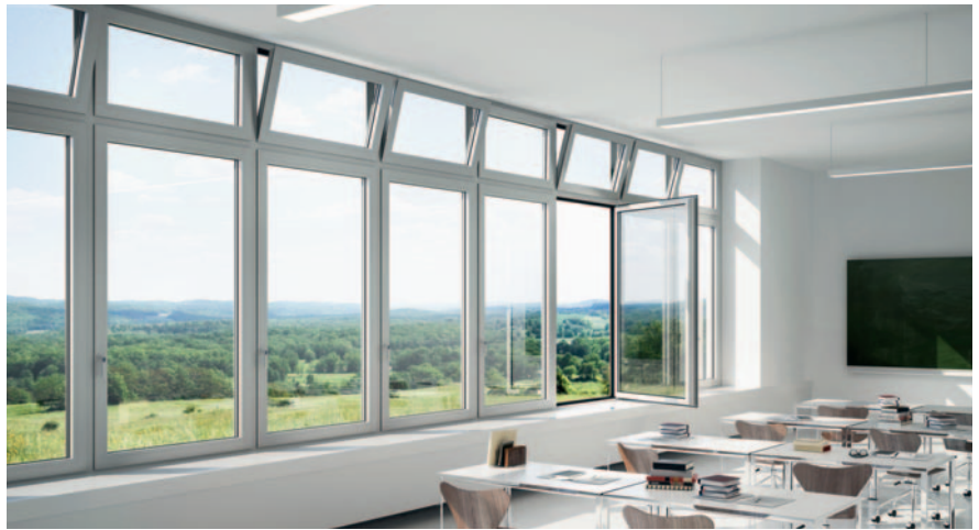
Gestion groupée des ouvertures Grouped management of windows
