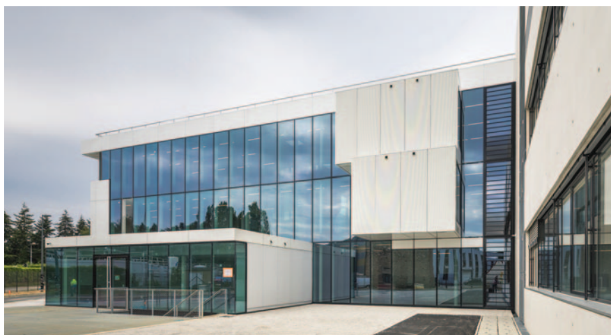
Centre de Recherche Loges en Josas - Air Liquide - Architecte Michel Remon - Sergio Grazia
